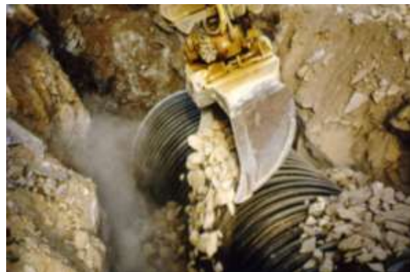
Maskinell tilfylling med 40-160 mm selvkomprimerende pukk på 20000 rør.
