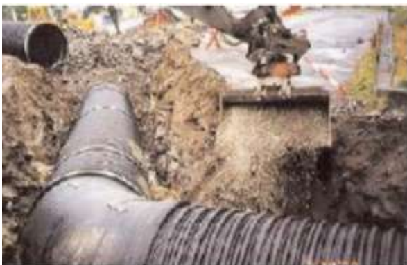
8-32 mm pukk tilfylles maskinelt.
