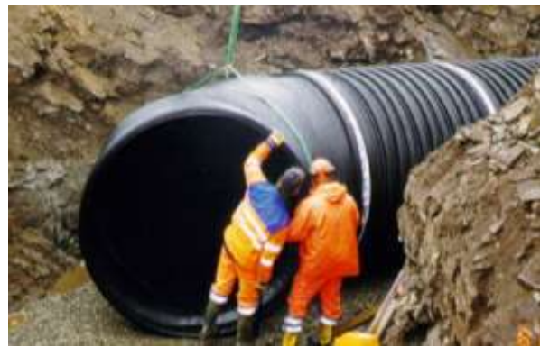
200—60 gr bend monteres i Hammerfeat på Fugleneset.
