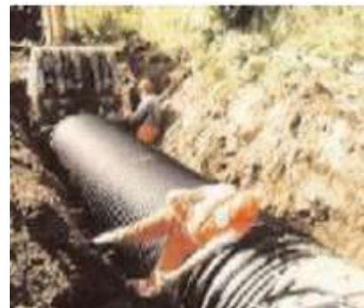
Maskinell installasjon. Gravemaskinskuffe med mellomlegg benyttes forsiktig.
