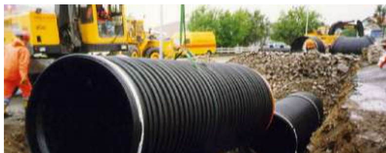
Installasjon og legging av \varnothing 2000 Haplast profilrør i Hammerfest.
