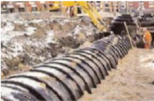
Rør og kum monteres
