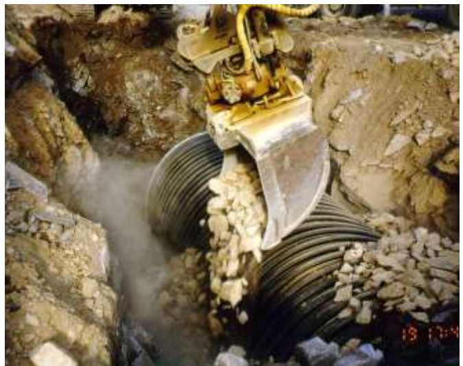
Maskinell tilfylling av 40-160 mm selvkomprimerende pukk i sprengt fjellgrøft. Røret er tilfylt under med 8-22 mm knust singel opp til ca 45 grader oppunder.
