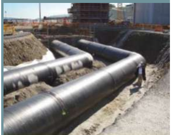
Lossing av DN 2.000 profilrør
