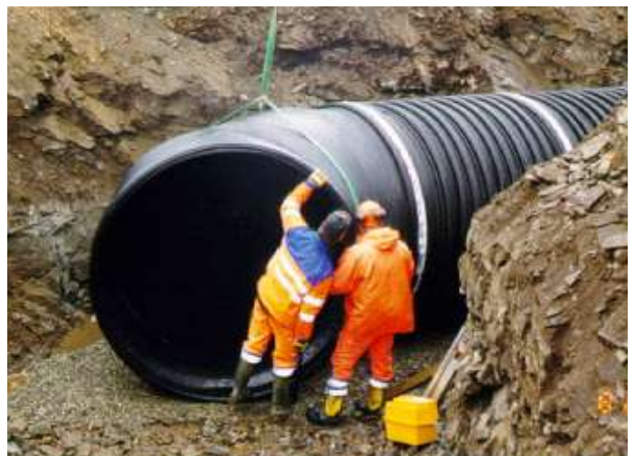
Montasje av Ø 2000 60 grader Haplast profil bend.
