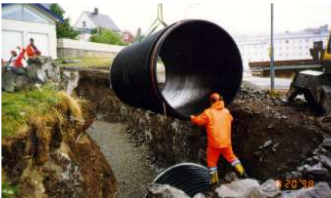
\varnothing 2000 Haplast Profilrør under installasjon. Lett og hurtig montasje.
