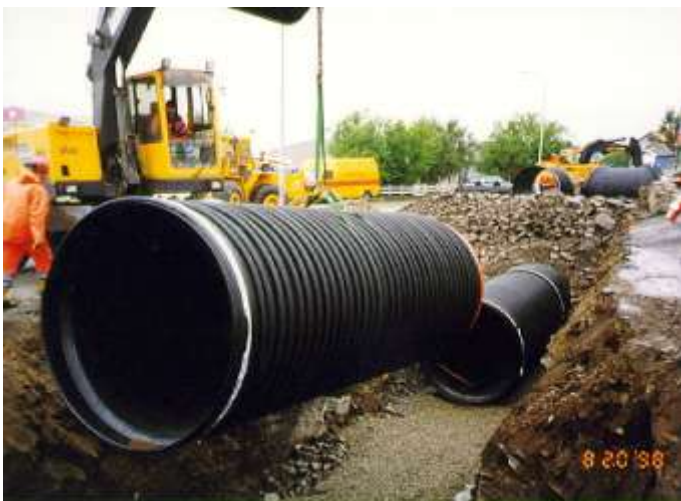
Installasjon og legging av Ø 2000 Haplast profilrør i Hammerfest.
