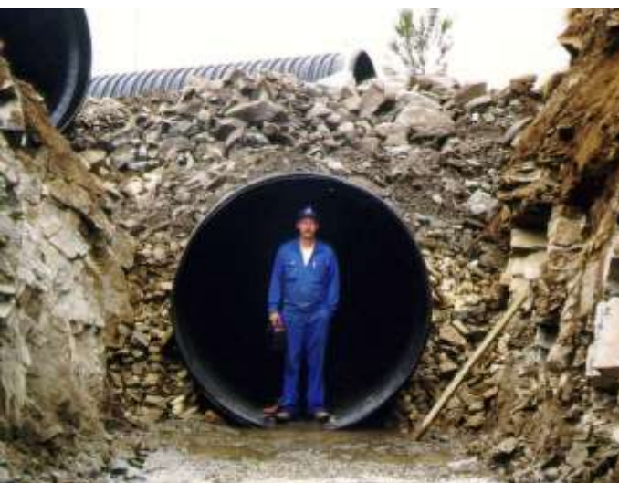
Omfilling av Ø 2000 Haplast profilrør i sprengt grøft. leggedypet er 3 - 4,5 m.
