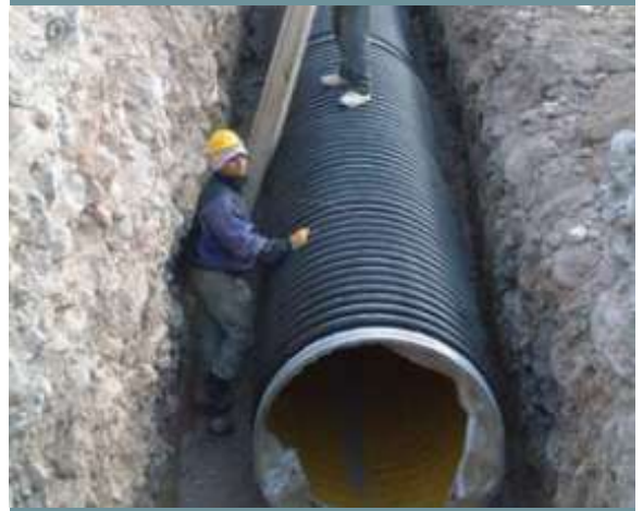
Installering i en smal grøft
