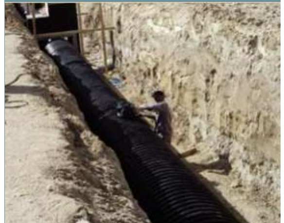
Installering av rør
