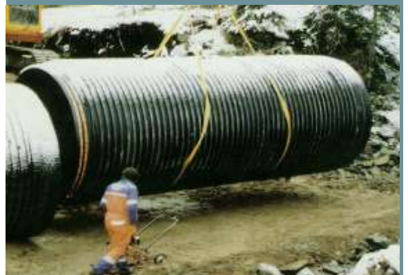
Enkel handtering av DN 2.500 profilrør
