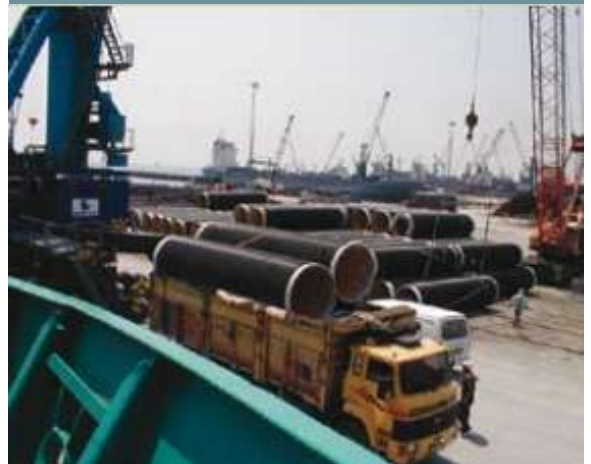
Enkel rørtransport fra havn til byggeplass.
