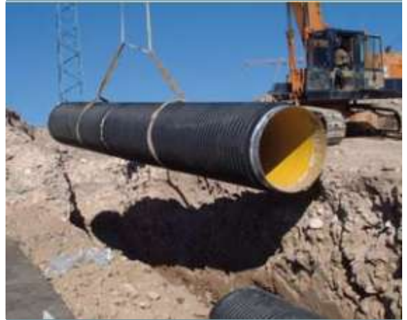
Installasjon av 2 stk ferdigmonterte DN 1600 rør med byggelengde 12 meter.
