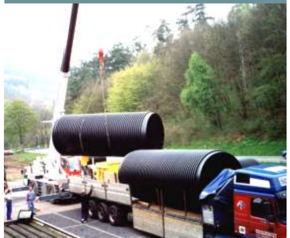
Lossing av DN 2.000 profilrør
