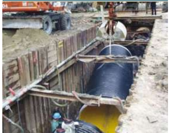
Spillvanns - overvann DN 2000 mm.
