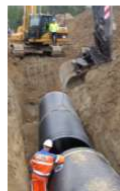
Rørene er klare for å bli montert sammen.
