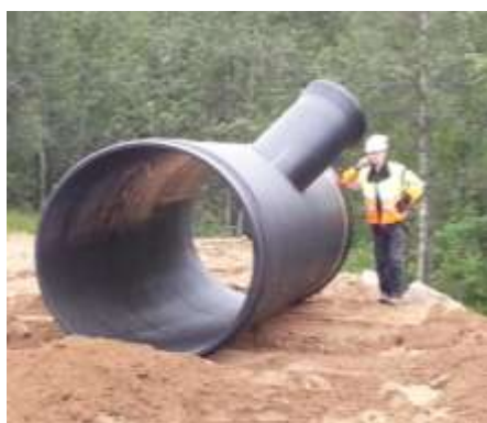
Det var enkelt å ta inn et sideløp rett inn på rørstammen. Stort sett ingenting er umulig.
