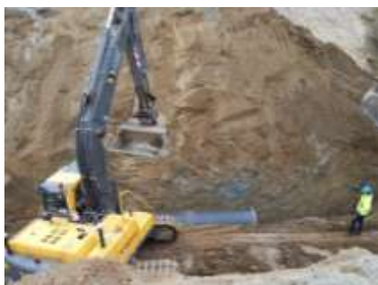
Langt der nede er røret.
