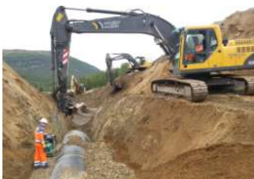
Det Tilfylling med selvkomprimerende masser
