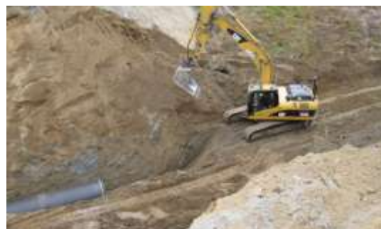
Det klargjøres for montering av det neste 6 meters strekket. Straks rørene er montert kan disse omfyllles.
