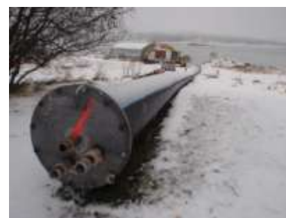
Bildene viser sjøledningen klar for legging og ilandføring på Kvaløya og på Tromsø øya.. Under ses detalj fra buttsveising.
