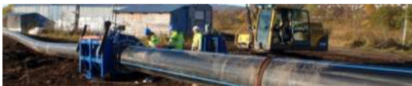
Bildene viser sjøledningen klar for legging og ilandføring på Kvaløya og på Tromsø øya.. Under ses detalj fra buttsveising.
